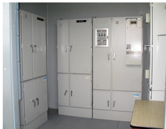
Manöverskåp i en nätstation (Foto SAAB Östersund)
